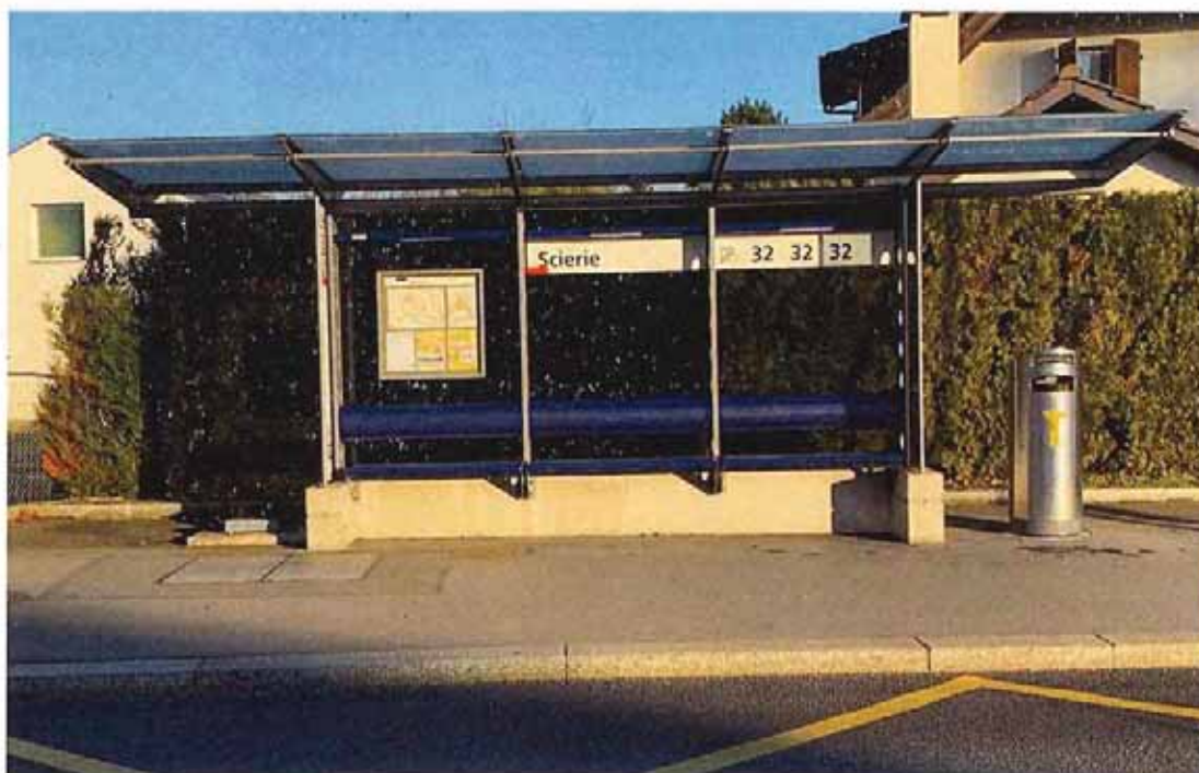
Figure 19 : Exemple de l'abri projeté pour le PP5
